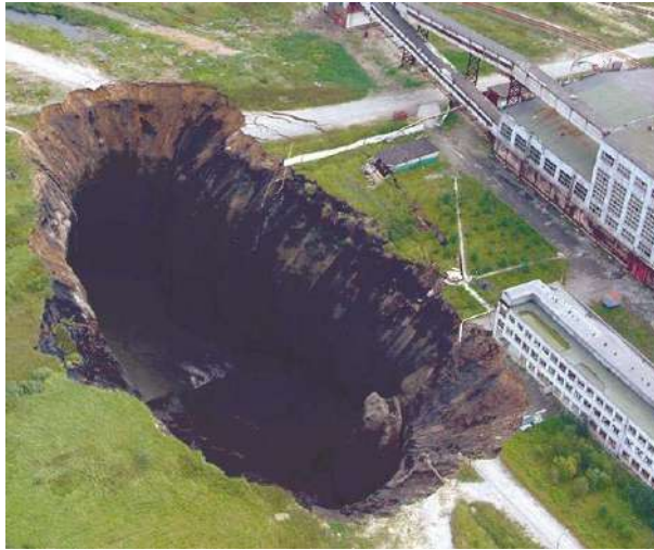
Fig. 6. Cave-in in Berezniki city at BKRU-1, October, 2006. Рис. 6. Провал в г. Березники на БКРУ-1, октябрь 2006 г.
